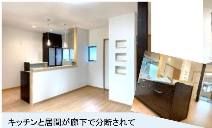
キッチンと居間が廊下で分断されていたのですが、壁を取っぱらい、<sup>ひとま</sup>一間続きにしました。明るく開放的なダイニングキッチンになりました。天井と壁のクロスは同じものにしたほうが、空間を広く見せることができます。今回、解体していく中で「抜けにくい柱」(抜くと強度が落ちる)が2本あったのですが、1本は魅せる柱、もう1本は壁を作りニッチを設けました。
