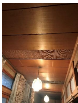
天井に雨漏れの跡が。屋根に上がって原因を探ったら、フェルトが傷んでいる箇所が見つかりました。フェルトを仕替え、その部分の瓦を葺き直しました。
