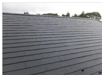
屋根の塗装をしました。下塗り、中塗り、仕上げと3回塗っています。
