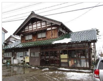
古民家の解体をしました
