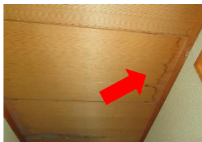
天井に雨漏れの跡が。屋根に上がって原因を探ったら、フェルトが傷んでいる箇所が見つかりました。フェルトを仕替え、その部分の瓦を葺き直しました。
