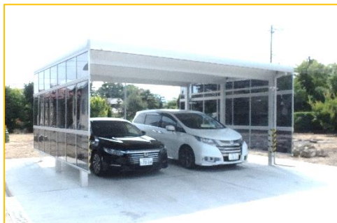
カーポートを設置させていただきました。
