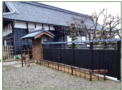
塀のリフォームをさせていただきました。
