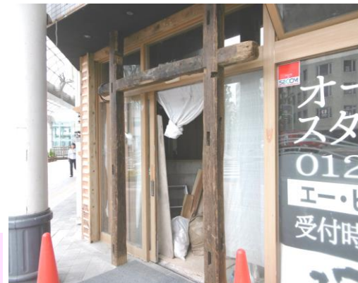
工事中の写真ですが、店舗入口
