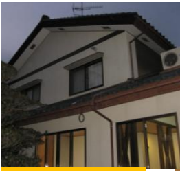
外壁の張替工事
